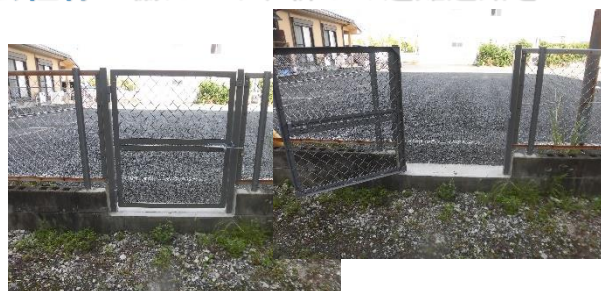
フェンスに扉を付けたことで安全かつ速やかに 避難することができます
